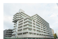
千里中央病院 (大阪府豊中市)
